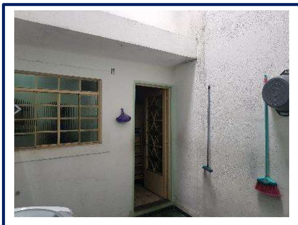
FOTO 18. Foto mostrando a Entrada da Casa B.
