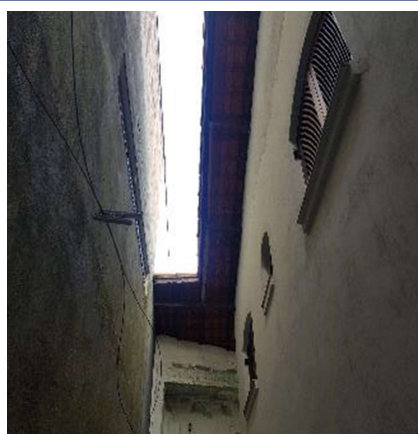
FOTO 3. Foto mostrando corredor lateral com vista da parte superior.
