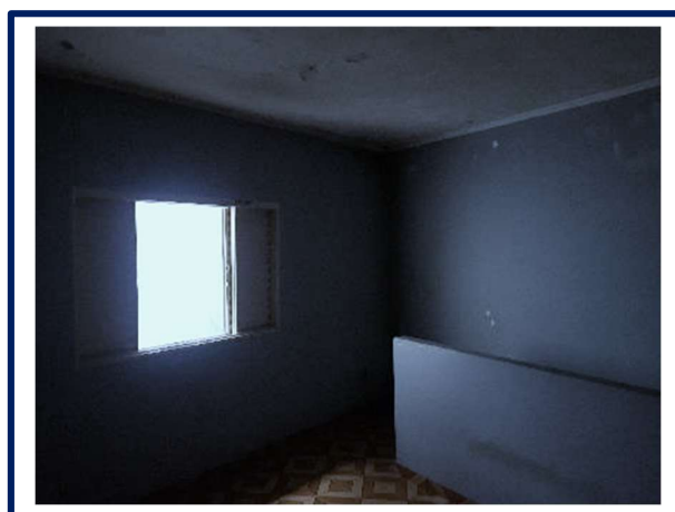
FOTO 23. Foto mostrando o Dormitório e escada.
